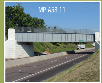
Thru-Plate Girder – 49
